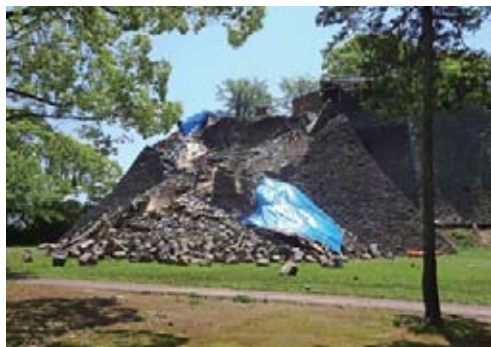
崩れた熊本城
